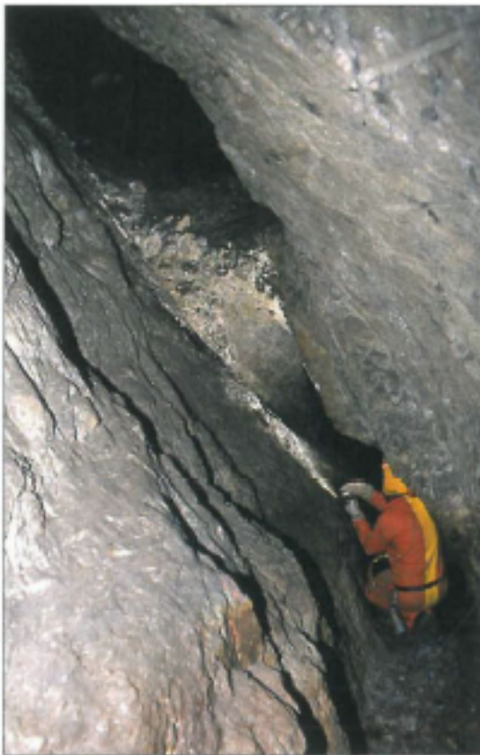
Abb. 1 Noch im Originalprofil erhaltener Abbau von etwa 1510 im obersten Abschnitt des Alten Schachtreviers, ca. 10 Meter unterhalb des Sigmund-Erbstollens, Bergbau Schwaz/Falkenstein. Da diese Gänge vielfach randliche Imprägnationen zeigten, wurden diese Zechen nach 1680 oft beträchtlich geweitet (Einführen der Schießtechnik, verbesserte Aufbereitungstechnik) (alle Fotos dieses Beitrags wurden vom Autor zur Verfügung gestellt).
