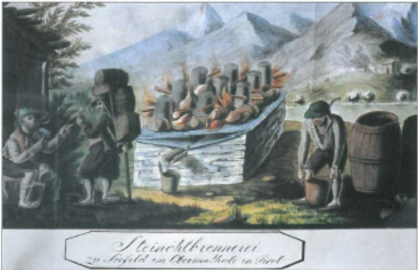
Abb. 10 Darstellung einer „Steinölbrennanlage“, wie sie etwa vor 150 Jahren (und auch noch später) betrieben wurde. Wie das Ausbringen des Steinöls im 16. Jahrhundert erfolgte, ist nicht näher bekannt.
