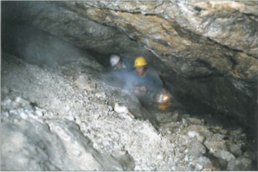
Abb. 2 Zeche an der Steinerkluft, Sohlbau des Kreuzstollens, Teilrevier Burgstall des Ringenwechsel, Bergbau Schwaz. Vererzung an einer „Kluft“ mit remobilisierten Fahlerzen; um 1500–1550 gebaut. Wegen des Fehlens seitlicher Imprägnationen oder Aufsitzer erfolgte kein späteres Nacharbeiten. Generell arme Vererzungen an alpidischen Scherflächen.
